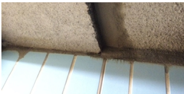
Bild 7: Verschluss sämtlicher Mauerfugen und Risse
