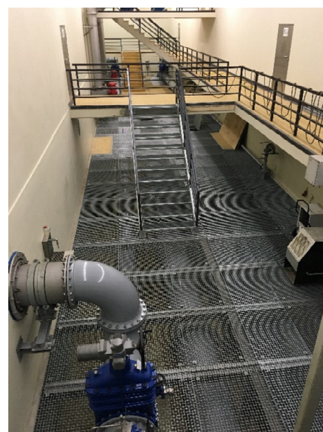
rechts Bild 5: Zugangsbereich zu den Reinwasserkammern
