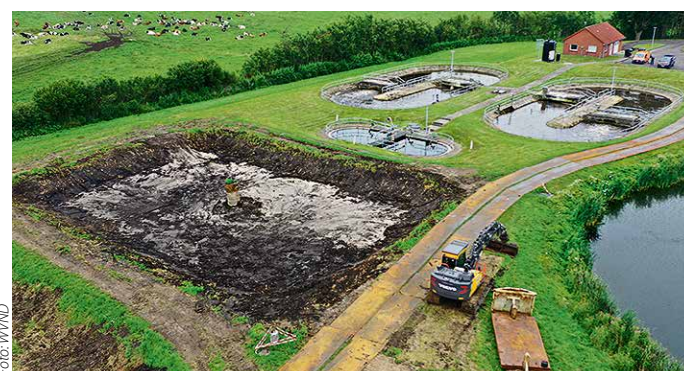
Schwere Technik beräumte den Polder an der Kläranlage in Hamdorf.
