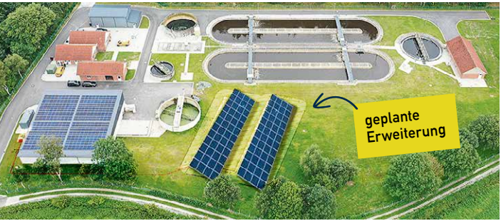
Am Standort der Kläranlage Lohe-Förden wird die vorhandene Photovoltaikanlage (98 kWp) durch eine weitere auf der geeigneten Freifläche (175,9 kWp) ergänzt. Mithilfe der Sonne erzeugt der WVNV hier künftig 273.000 Kilowattstunden Strom aus Erneuerbaren Energien.
