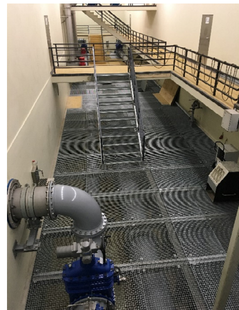
rechts Bild 5: Zugangsbereich zu den Reinwasserkammern
