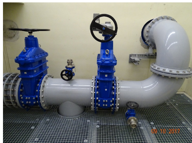
Bild 10: Absperrarmaturen Reinwasserkammer
