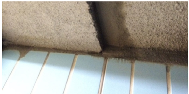
Bild 7: Verschluss sämtlicher Mauerfugen und Risse
