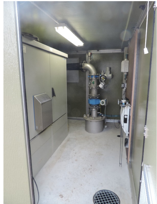
Bild 1: Blick in das oberirdische Brunnenhaus
