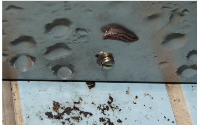
Bild 6: Schneckenbefall in Reinwasserkammer
