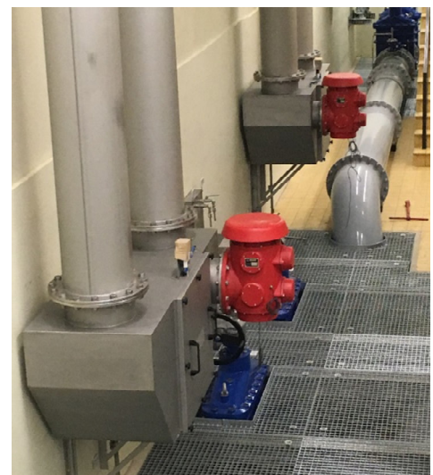
Bild 9: Filtereinheit, 2-fach
