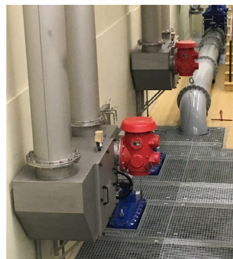
Bild 9: Filtereinheit, 2-fach
