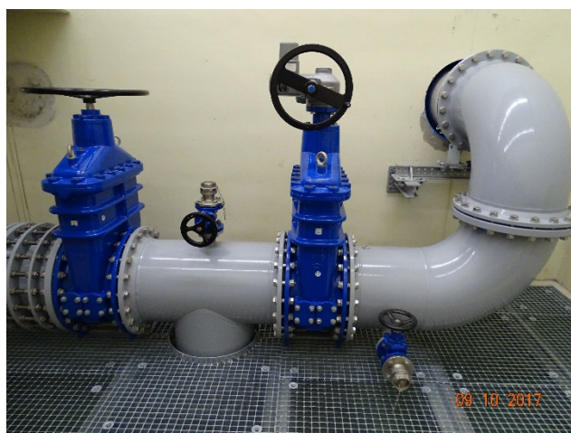
Bild 10: Absperrarmaturen Reinwasserkammer
