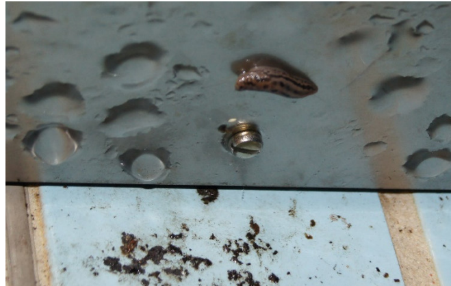
Bild 6: Schneckenbefall in Reinwasserkammer
