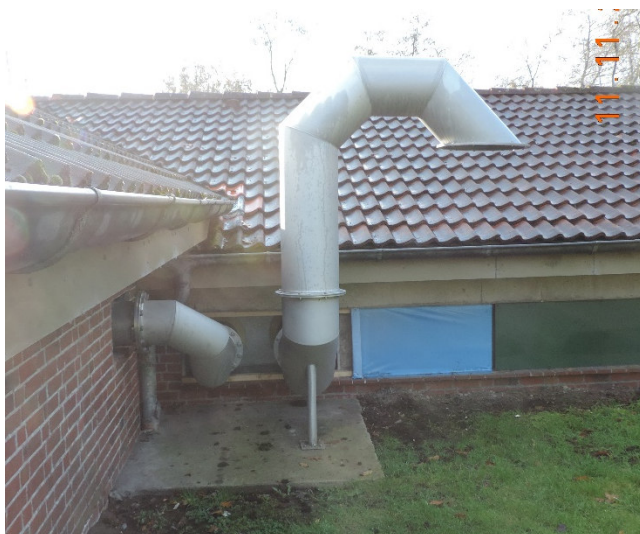
Bild 8: Zu- und Abluftanlage Reinwasserbehälter
