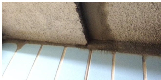
Bild 7: Verschluss sämtlicher Mauerfugen und Risse
